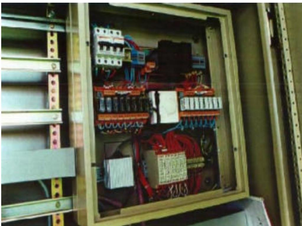
*Voici l'interrupteur se trouvant en tête du circuit ainsi que le groupement de 4 disjoncteurs commandant l'éclairage.*
